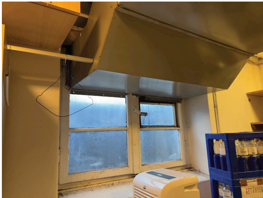
Abb. 48: Ansicht des Fensters von innen mit dem integrierten Lüftungskanal.
